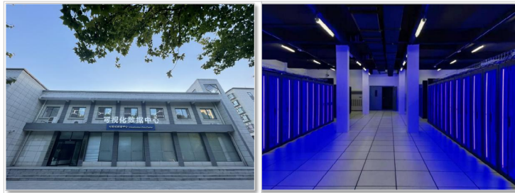
图 2 可视化数据中心
